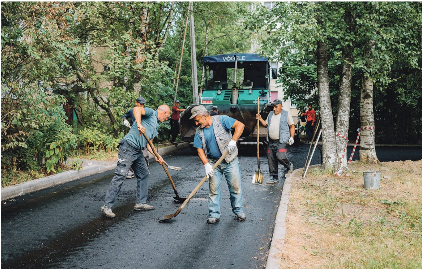
Замена асфальта на улице Турку, 8/5
